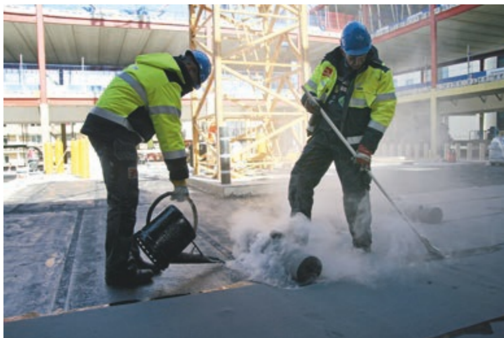
Figur 10: Klebing med varm asfalt
