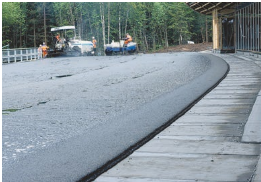
Figur 13: Parkeringsdekke med veiasfalt lagt direkte på sveisemembran
