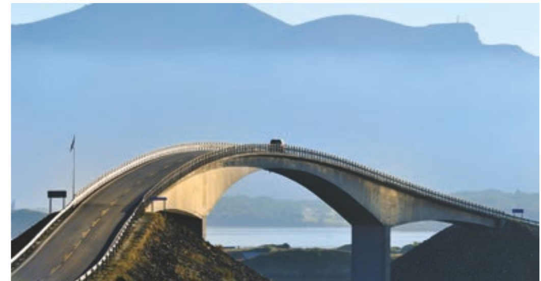
Figur 18: Storseisundbroen på Atlanterhavsveien er et eksempel på bruk av bromembran. Foto: Jarle Wæhler, Statens vegvesen
