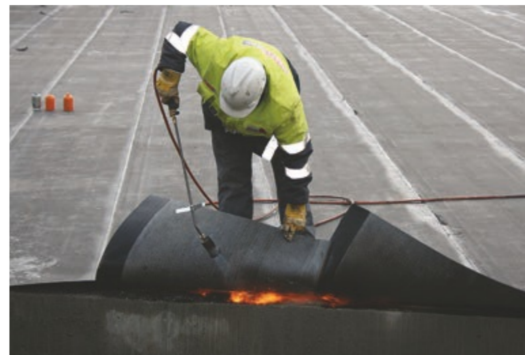
Figur 11: Helsveising av membran på parkeringsdekke
