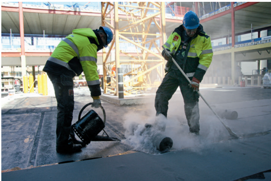
Figur 10: Klebing med varm asfalt
